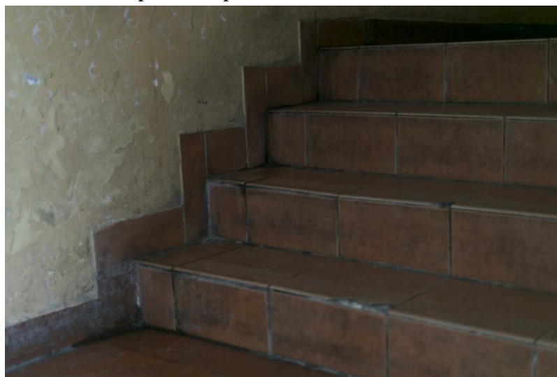
Fot. 18. Detale posadzki parteru z uwidocznieniem zawilgoconej ściany
