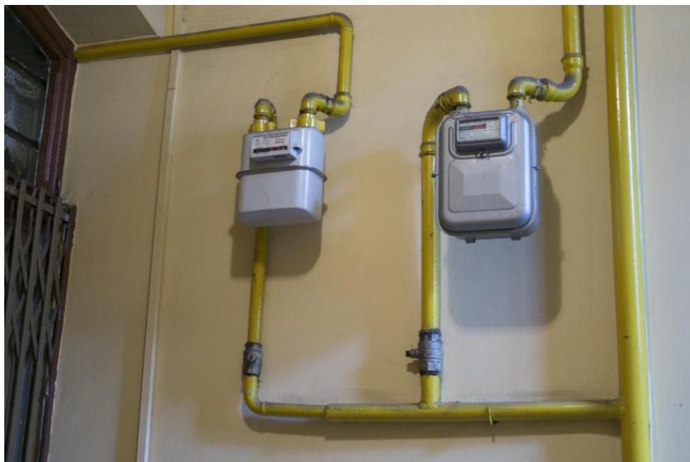
Fot. 35. Instalacja gazowa z licznikami
