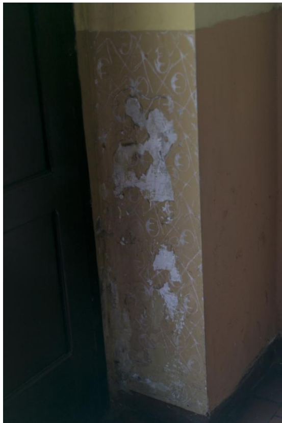
Fot. 19. Złuszczająca się farba na tynku parcie
