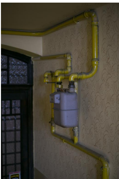
Fot. 34. Odstające liczniki gazowe
