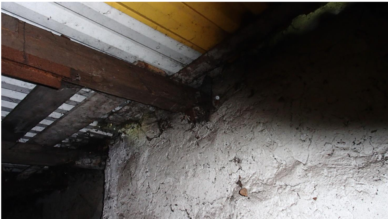
9. Połączenie belek dachowych z ścianą.
